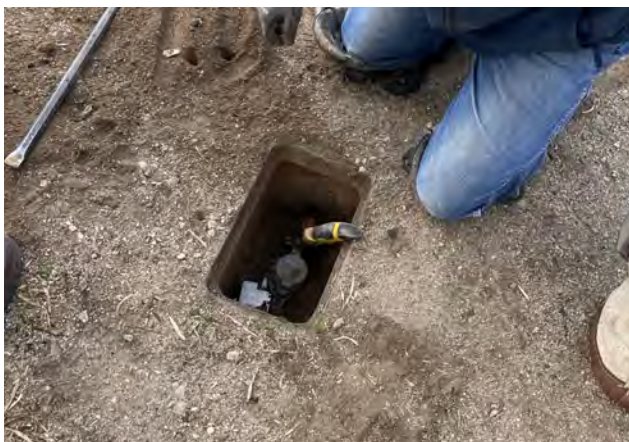
Técnico de Tucson Water instalando un medidor inteligente ultrasónico
