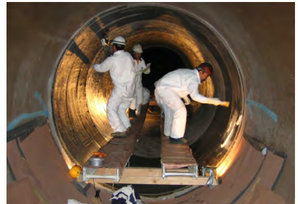
96" Reparación de tuberías
