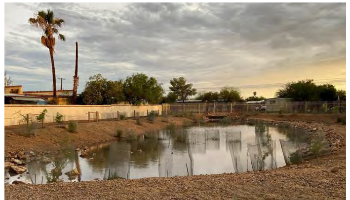
El proyecto de captación de aguas pluviales de Cherry Avenue captura y retiene hasta 77.049 galones de aguas pluviales en una cuenca con vegetación de dos celdas, mitigando las molestas inundaciones en el vecindario circundante.
