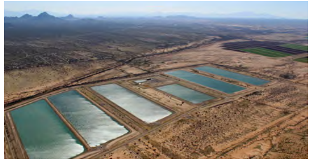
Vista aérea del proyecto de almacenamiento y recuperación del valle del Avra Central
