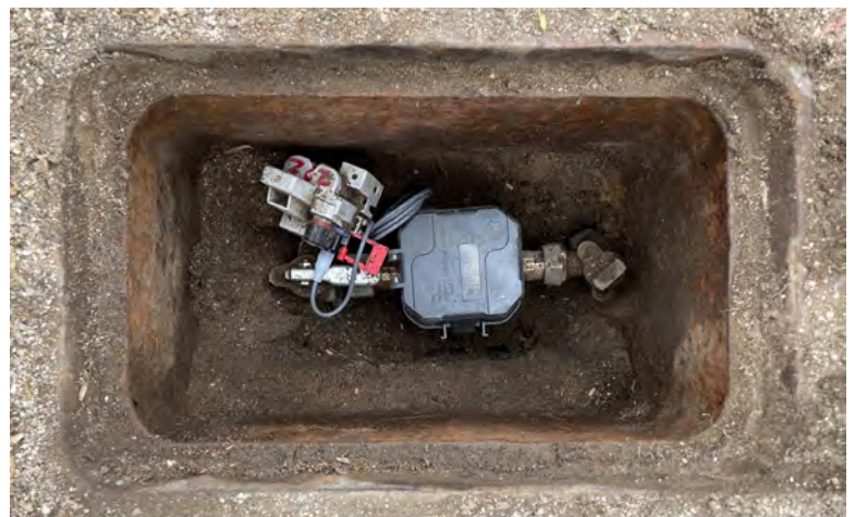
Técnico de Tucson Water instalando un medidor inteligente ultrasónico
