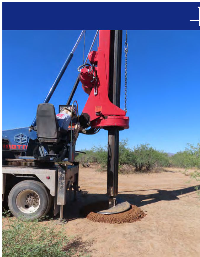
Personal de Tucson Water instalando un nuevo filtro en el pozo AV-001B
