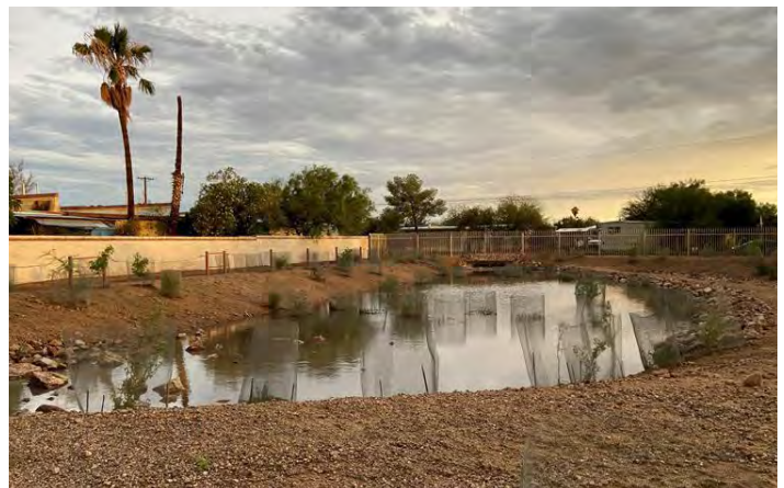
El proyecto de captación de aguas pluviales de Cherry Avenue captura y retiene hasta 77,049 galones de aguas pluviales en una cuenca vegetada de dos celdas, mitigando las molestas inundaciones en el vecindario circundante.
