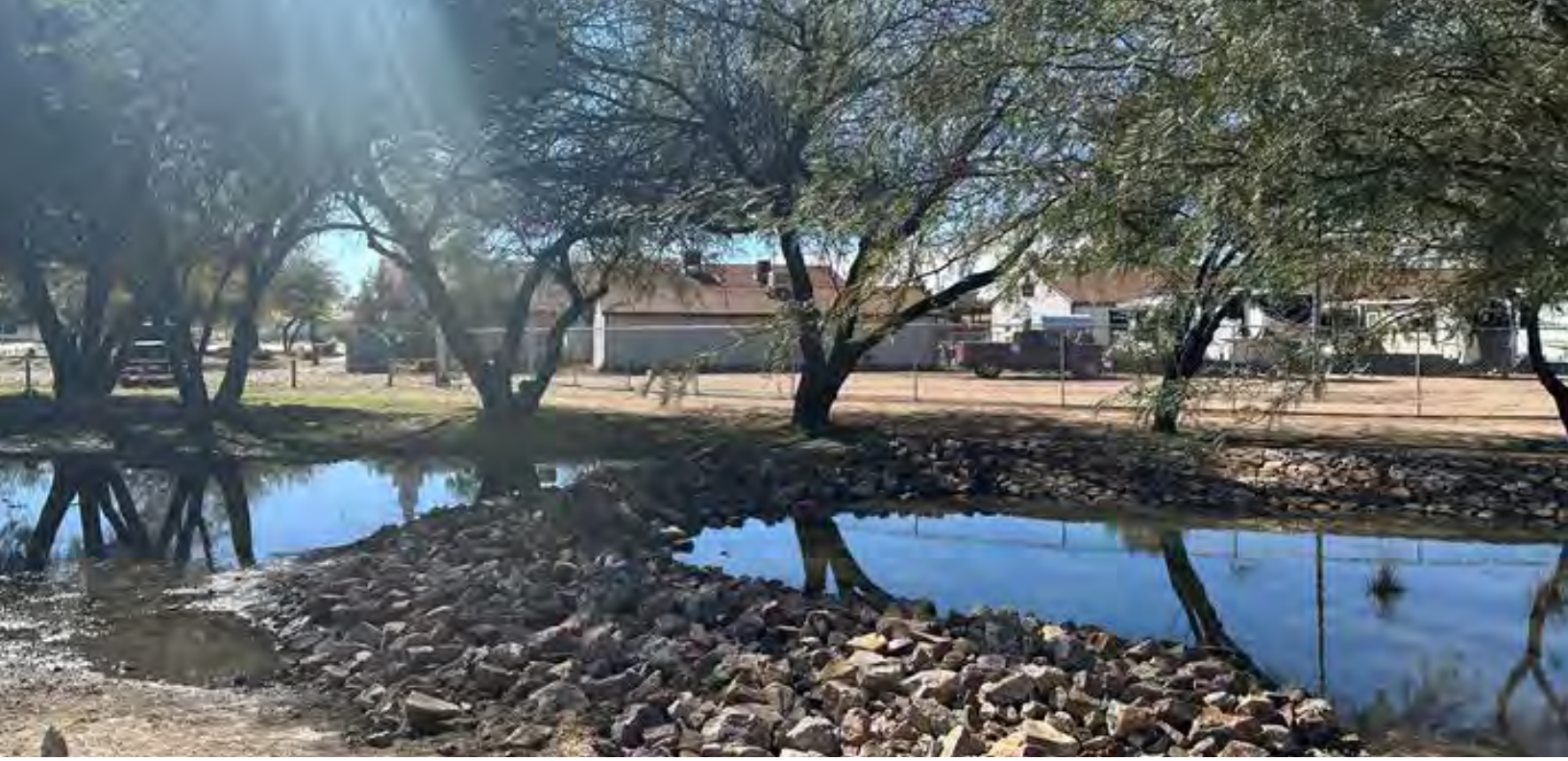
El proyecto del parque de aguas pluviales de El Vado aprovecha la escorrentía de las aguas pluviales del barrio adyacente y la utiliza para mantener un bosque nativo y autosuficiente de alimentos en beneficio de la comunidad local. Las cuatro cuencas de 2 pies de profundidad tienen una capacidad total de 400.000 galones.
