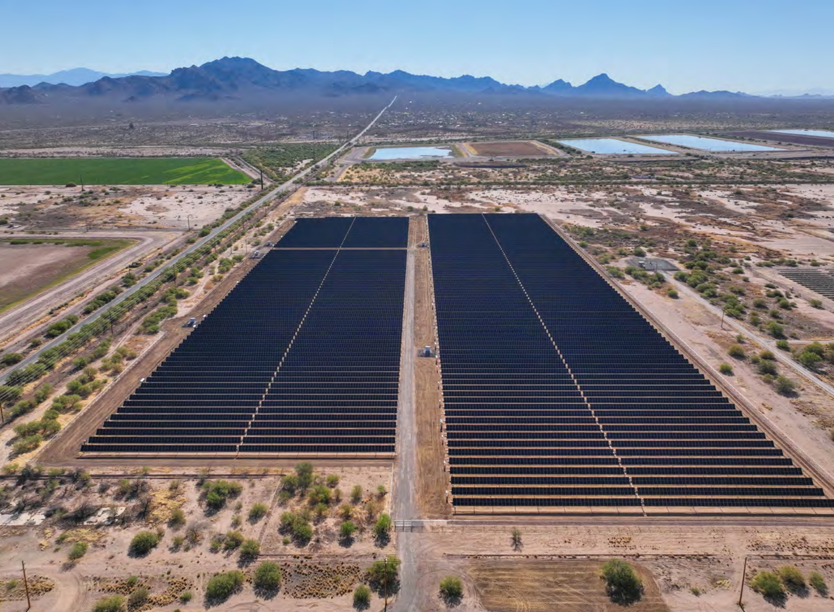
La planta solar del CAVSARP.
