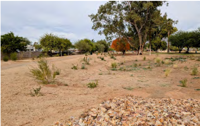
Depósito de recolección de aguas pluviales en el proyecto del parque Alvernon.
