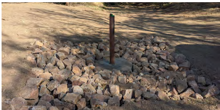
Dispositivo de medición de flujo para medir la velocidad del flujo de aguas pluviales en el Proyecto de Cuenca de Detención Rita Ranch.
