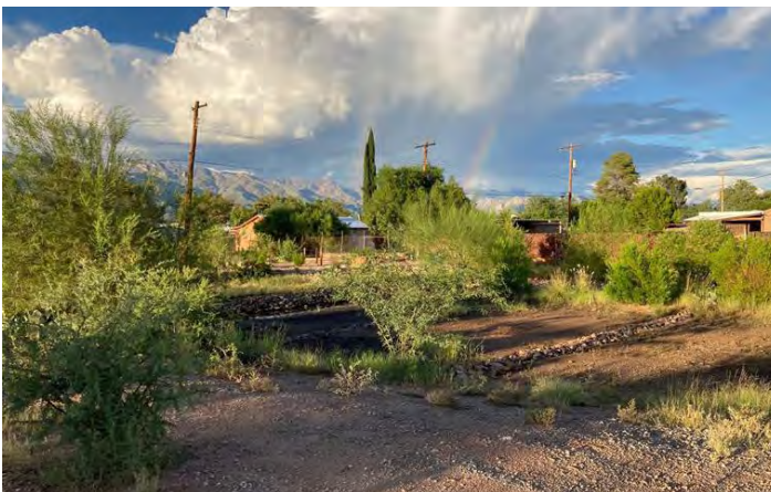
La cuenca Seneca fue diseñada y construida por el condado de Pima en una propiedad de 1,67 acres para combatir las inundaciones que durante décadas han sufrido los barrios circundantes. La cuenca puede recoger 321,662 galones de aguas pluviales que fluyen desde la calle Seneca. La cuenca Seneca fue designada parque municipal en 2022.
