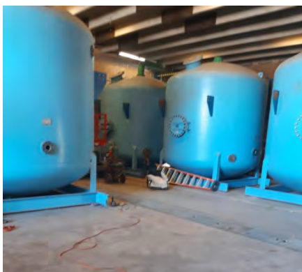
Antes y después de la retirada de los tanques de filtración de la Planta de Recuperación de Sweetwater. La sala ya está preparada para albergar los equipos de la instalación de demostración de AWP
