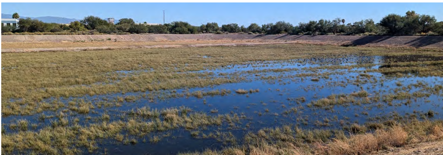
Recarga de agua regenerada en la Instalación de Recarga de Sweetwater, el primer proyecto de recarga y recuperación de Tucson
